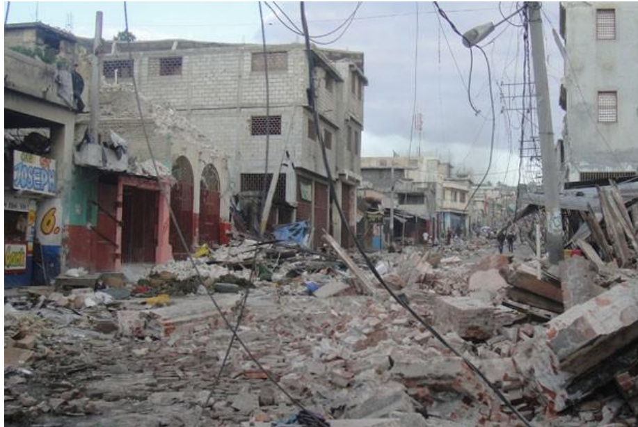
Figura 2: Rua bloqueada devido ao sismo.
